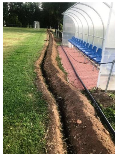
Öntözőrendszer épül
