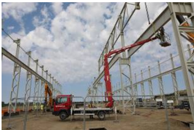
Épülnek az acél- és betonacél-összeszerelő komplexum épületei
