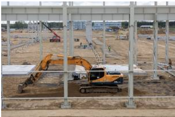
Dolgoznak a munkagépek az építési-szerelési bázison
